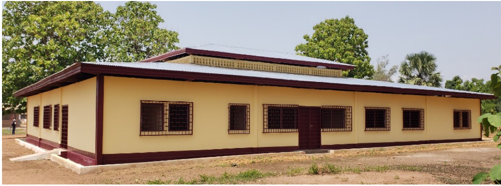
Après réalisation des travaux CPR Kaga -Bandoro-PAPSE II
